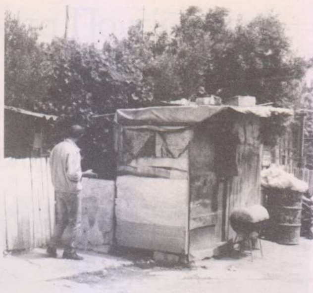
Η προσωρινή εγκατάσταση στο Λαύριο διαρκεί είκοσι-πέντε χρόνια (Αρχείο Μ. Βεργέτη).
