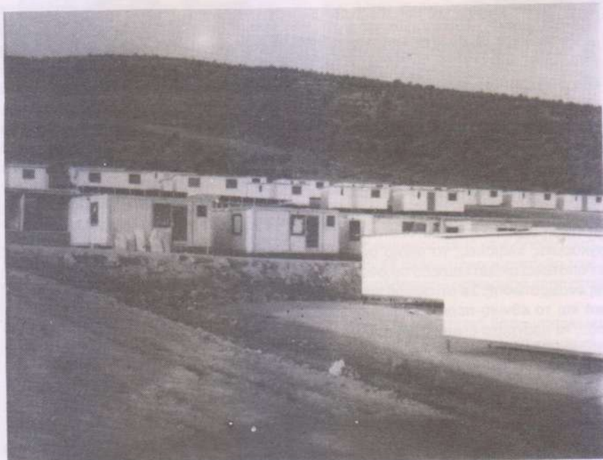
Άποψη του υπό κατασκευή οικισμού των παλιννοστούντων όμογενών στο χωριό Παλαγία του Έβρου
