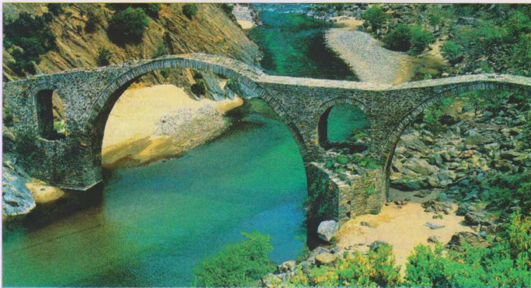
Η γέφυρα Κομψάτων Ροδόπης, Αίμπουμ Νίκου Λεσύλλα.
